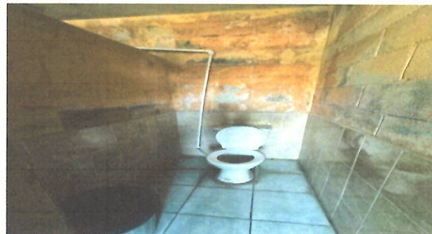
FOTO 2: SERVICIOS SANITARIOS Y SUS ACCESORIOS
