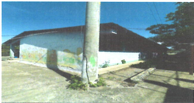
FOTO1: PINTURA EN MUROS INTERIOR Y EXTERIOR
