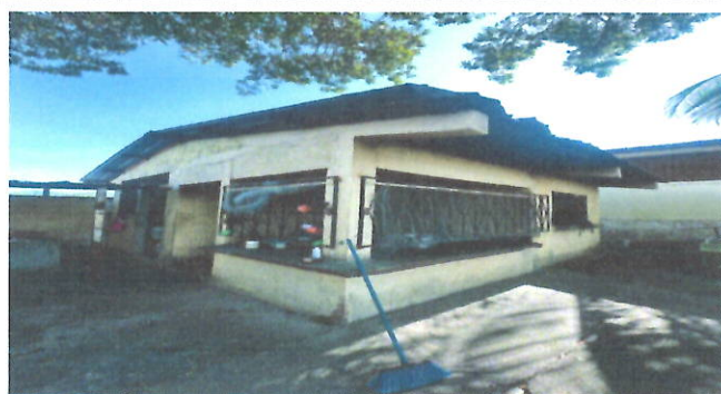
FOTO3: REPARACIÓN O SUSTITUCIÓN DE ÁREA DE COCINA
